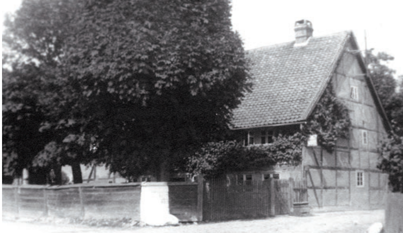
Farfars hus förstördes av bomber söndagen den 30 januari 1944.
