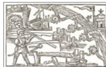
I Olaus Magnus historia om de nordiska folken förekommer denna illustration som visar en smideshärd med bälgar, drivna av vattenhjul, samt tre stångjärnshamrar, alla med vattenhjul.
